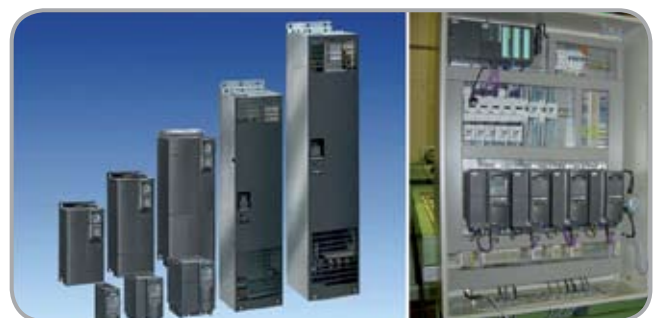
Regulación de Presión en las Bombas de Suministro
