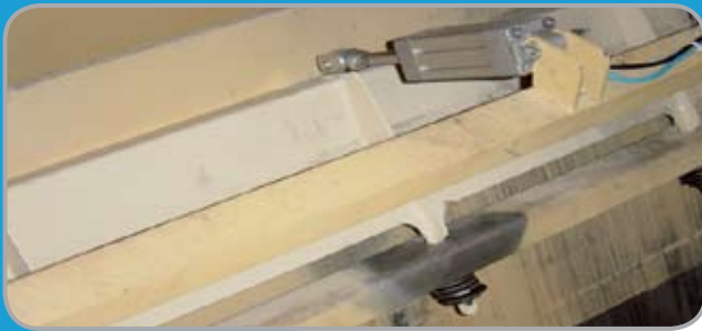
Compactador de Lodos
